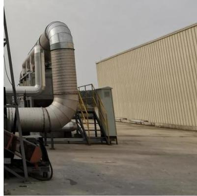
气旋混动喷淋塔+干式过滤器+活性炭吸附浓缩+催化燃烧装置（TA002）
